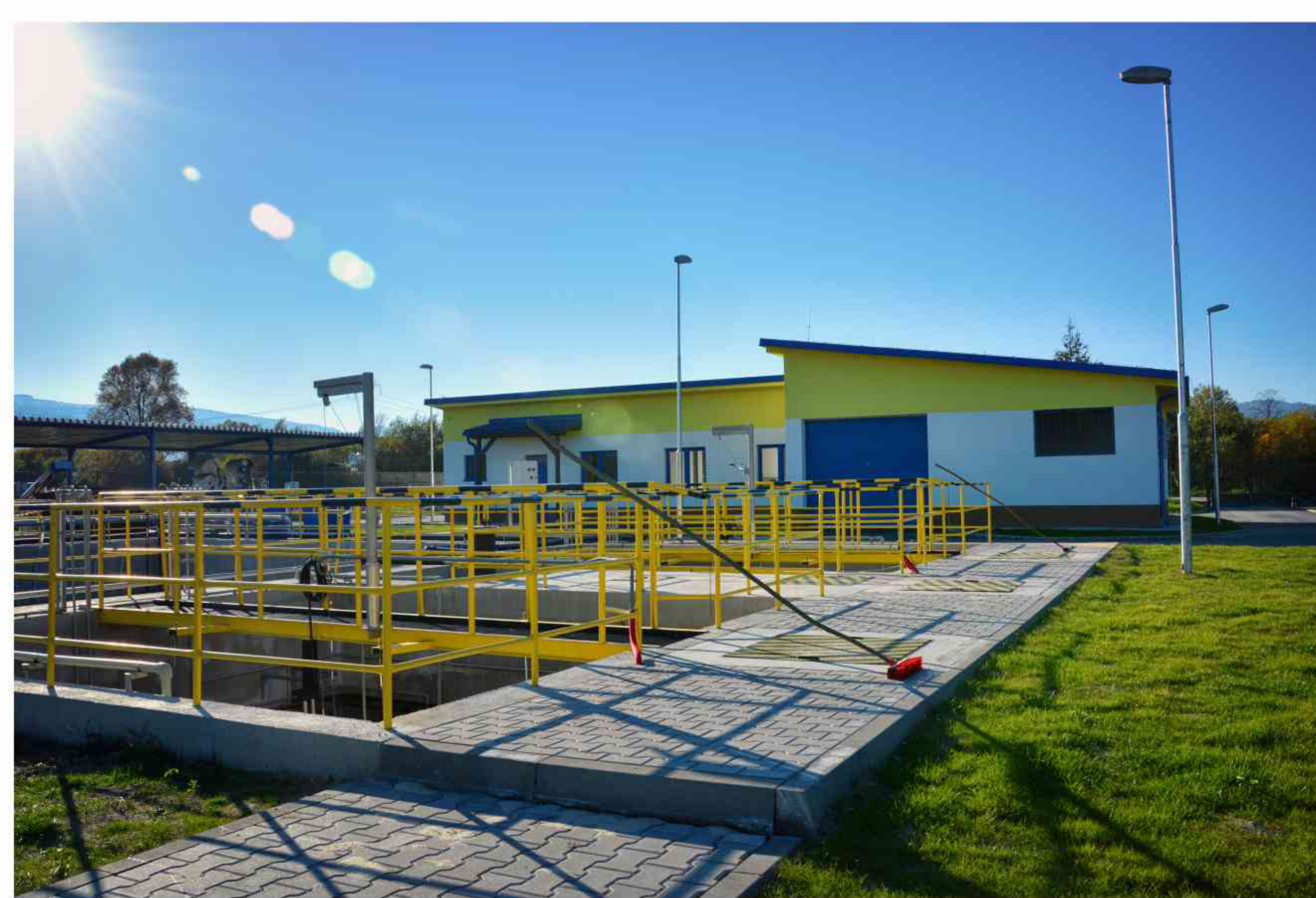
Foto č. 2: Súčasný stav po rekonštrukcii
