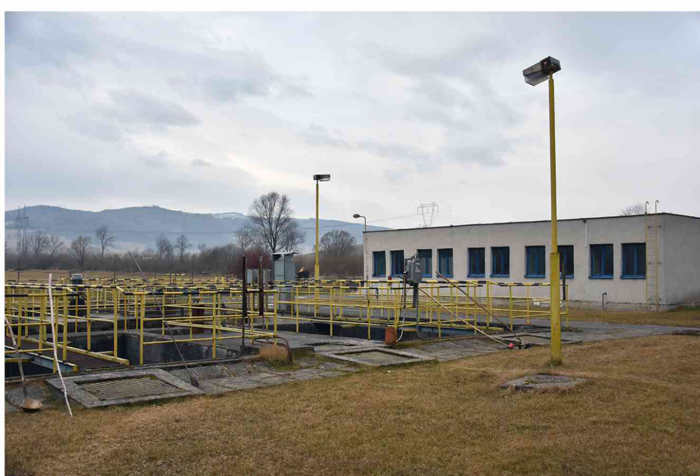
Foto č. 1: Pôvodný stav pred rekonštrukciou
