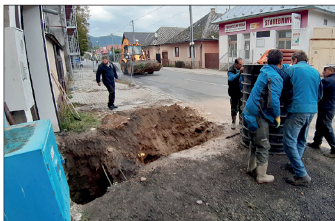
Osadenie vodomernej šachty
