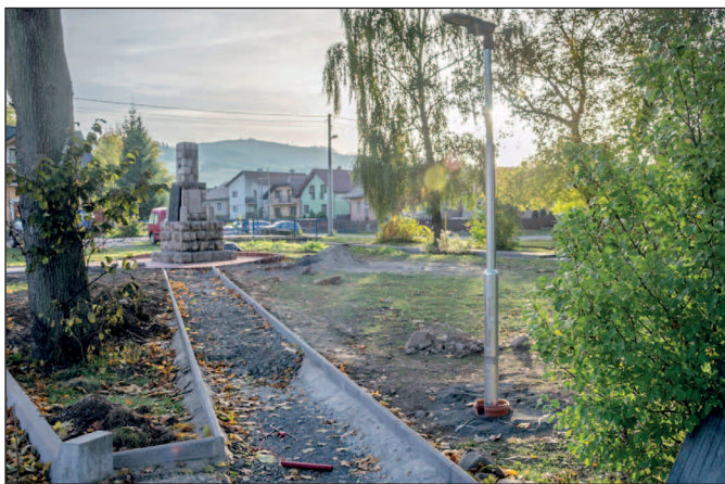
Práce na výstavbe chodníka v parku na ulici SNP
