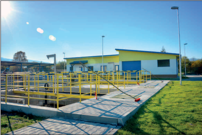
ČOV po dokončení
