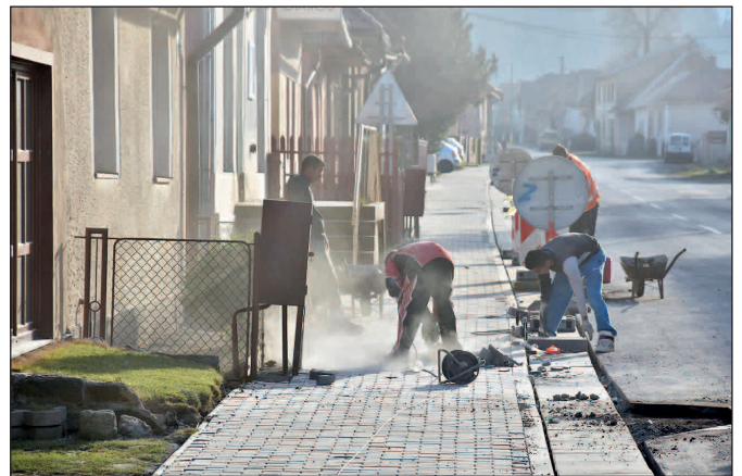
Záverečné práce na stavbe chodníka na ul. SNP
