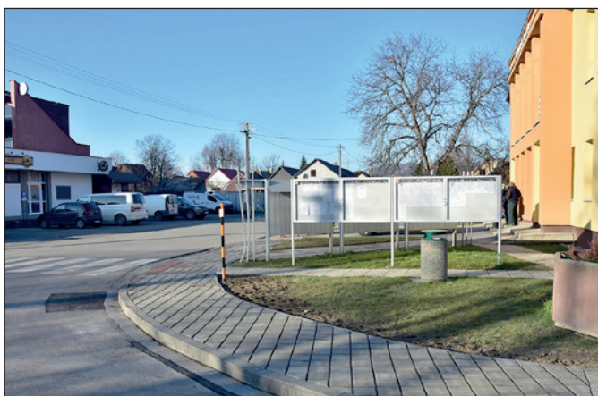
Dokončený chodník na Mierovom námestí
