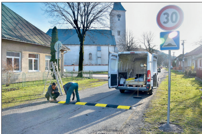
Montáž spomalovacieho prahu na ul. Hviezdoslavovej
