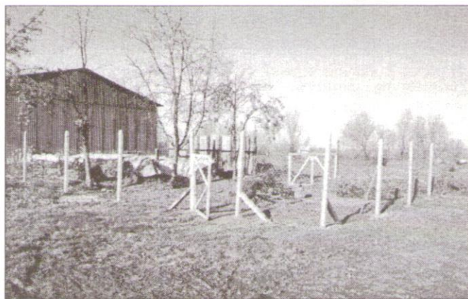
Novovybudované kompostovisko v obci Kokšov-Bakša pri Košiciach
