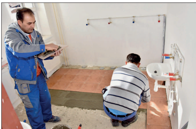
Rekonštrukcia sociálnych zariadení v priestoroch kultúrneho domu
