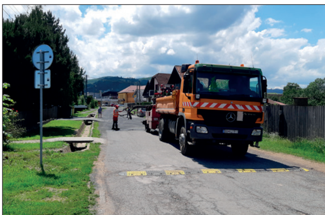
Vysprávky miestnych komunikácií
